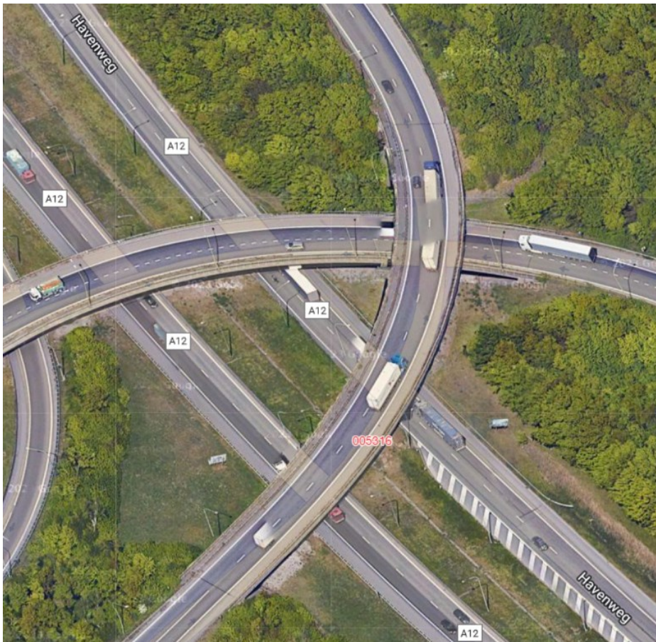
5316 Brug 57 in verkeersknooppunt A12 Noorderlaan
