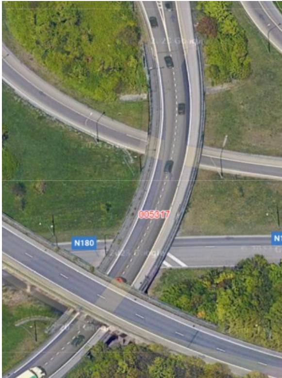
5317 Brug 54 in verkeersknooppunt A12 Noorderlaan
