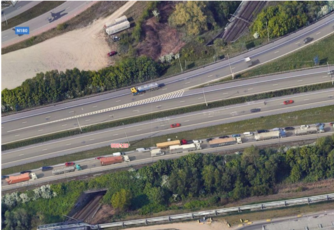
5120 Spoorwegkoker K2 Oost in R2 over spoorlijn
